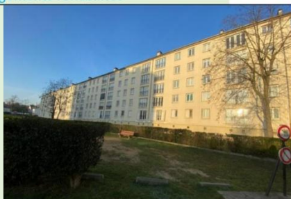
IN'LI – Chatou Audit énergétique de 272 logements
