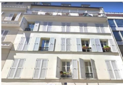
IN'LI – Paris Ganneron Audit énergétique de 24 logements
