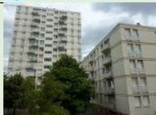
IN'LI Bagneux audit énergétique et programmation travaux de 343 logements - 2019
