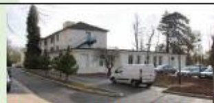
Mairie de Soisy sur Seine (91) Réhabilitation d'un bâtiment tertiaire en coworking MOE thermique et fluides 2018-2019
